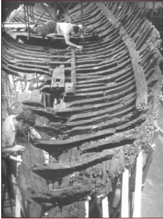
(شكل ١) حطام السفينة Kyrenia من القرن الرابع قبل الميلاد، بعد انتشالها وترميمها وتجميع أجزاءها مرة أخرى.
